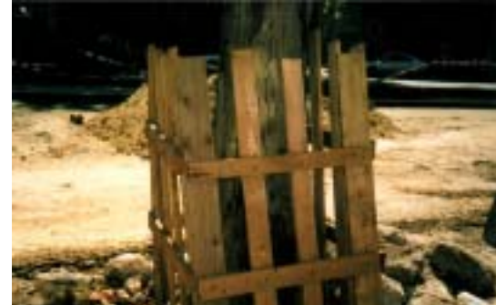
Fák védelme az építkezés alatt
